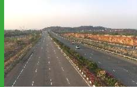
ORR Exit no : 14
